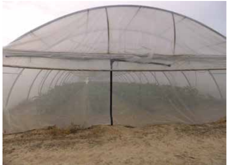
Tunnel 9,30 m, équipé de pignons porte-filet à fermeture éclair.
