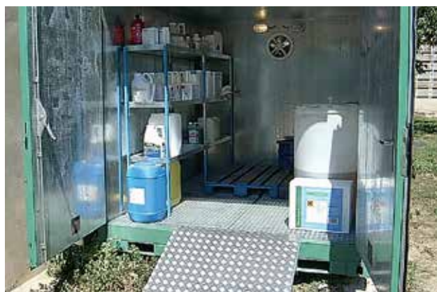
Le local phytosanitaire, élément important pour votre sécurité et celle de votre environnement, permet de limiter les risques d'accidents et/ou de pollution.
