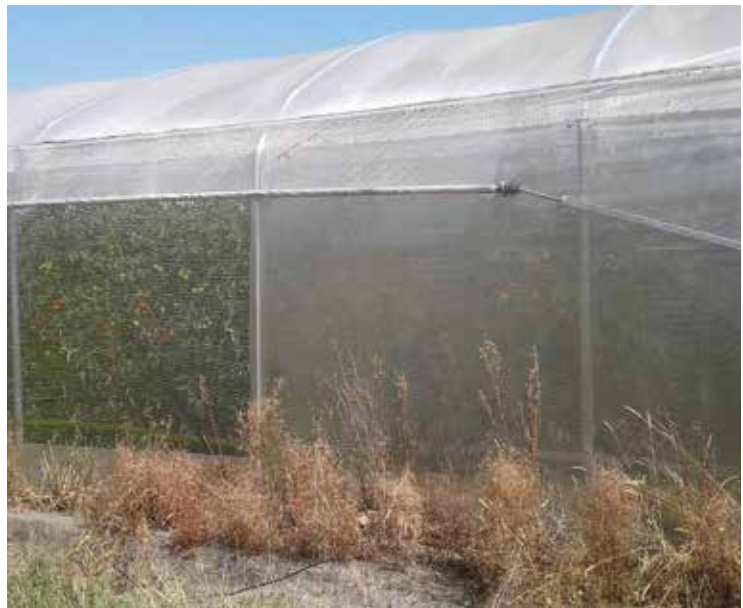
Autre type de tunnel avec aération latérale avec filet et enroulement du film plastique.
