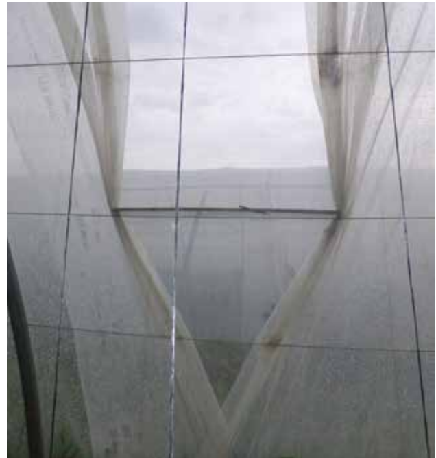
Filet positionné au niveau des écartements de bâches.
